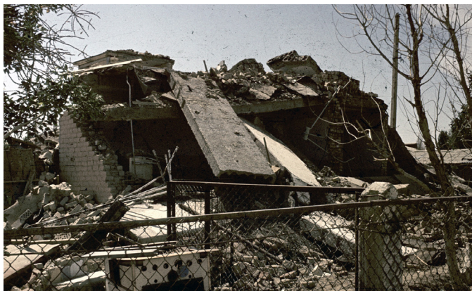
Типичное разрушение жилого дома при первом Газлийском землетрясении 1976 г. После второго толчка строение рухнуло полностью
