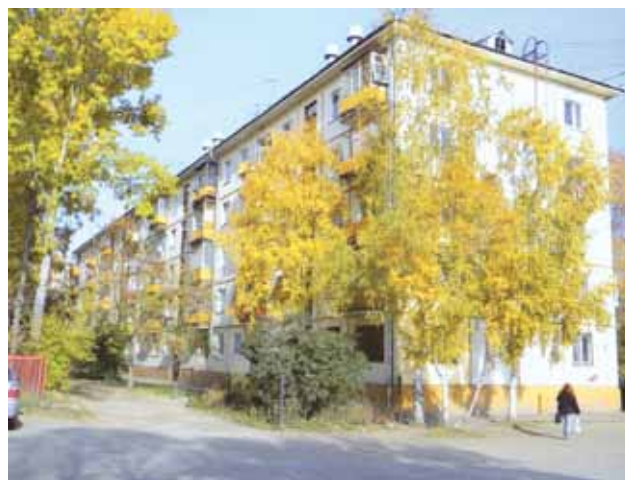
Рис.2. Жилой дом — представитель зданий серии 1-335, г.Иркутск, ул.Байкальская, 180
