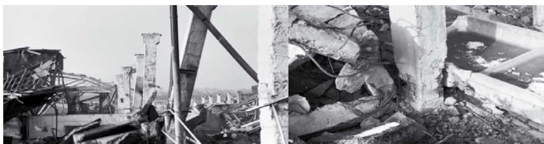
Рис.1. Одноэтажное каркасное производственное здание в г.Ленинакане
