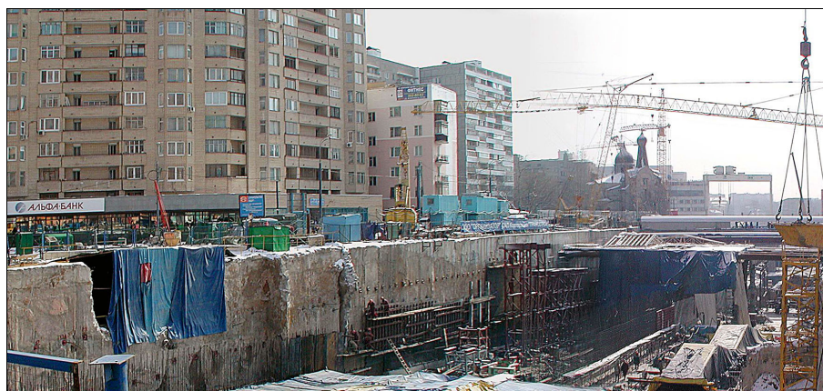
Рис. 3.1.3. Вид объекта со стороны строительства 3-го ТК (вид 1 на рис.3.2).
