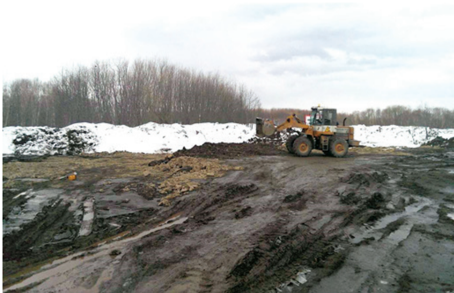
Рис. 2. Снятие верхнего двухметрового слоя
