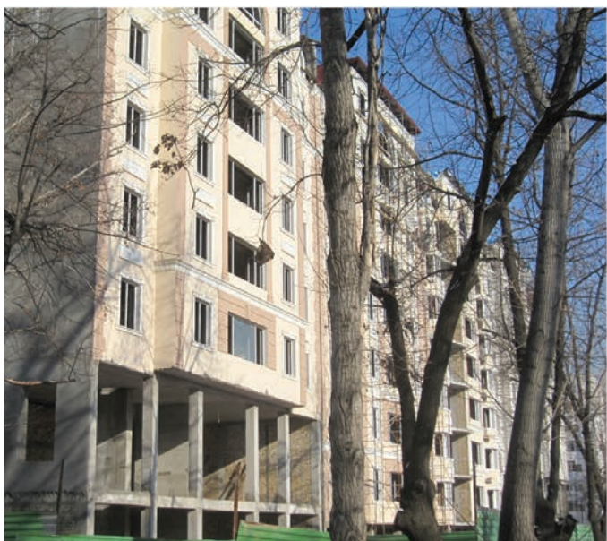
Рис. 5. Характерные для столичных городов Центрально-Азиатского региона жесткие здания с первыми гибкими этажами. Этот вид строительства не допускается нормами ряда Центрально-Азиатских стран либо допускается в ограниченном применении. Справа представлен вид повреждения зданий с гибким этажом после землетрясения в Сичуане (Китай), 12.05.2008 г., M=8,0 местечко Лонгман (автор фото слева – Ш.А. Хакимов, 2010; справа – www.zzs.iem.cn )
