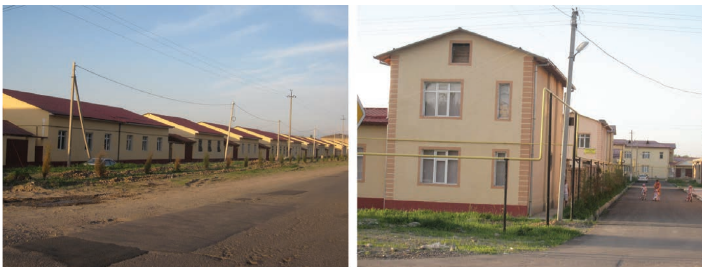
Рис. 3. Современные сейсмостойкие дома в сельских районах Узбекистана, построенные по типовым проектам (Ш.А. Хакимов, 2015)
