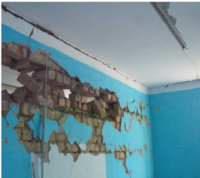
Рис. 4. Повреждения кирпичных зданий: а – после Каннского (2011 г. M=6,2 Киргизия). Интенсивность в зоне обследования 6–7 баллов; б – Марджанбулакского землетрясения (2013 г. M=6,0 , Узбекистан). Интенсивность в зоне обследования 6–7 баллов (Ш.А. Хакимов, 2011 г., 2013 г.)
