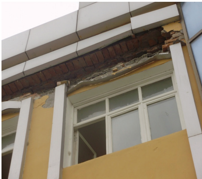
Рис. 4. Повреждения кирпичных зданий: а – после Каннского (2011 г. M=6,2 Киргизия). Интенсивность в зоне обследования 6–7 баллов; б – Марджанбулакского землетрясения (2013 г. M=6,0 , Узбекистан). Интенсивность в зоне обследования 6–7 баллов (Ш.А. Хакимов, 2011 г., 2013 г.)
