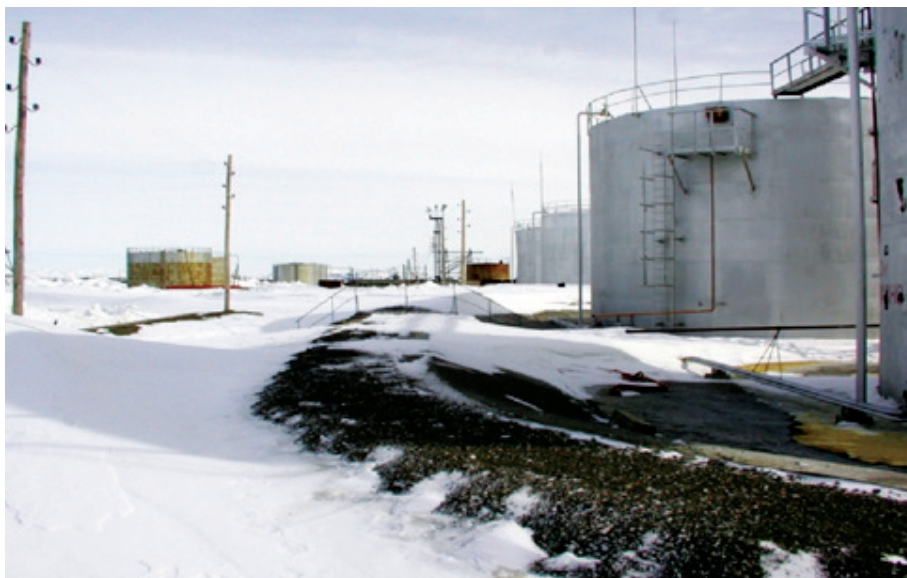
Рис. 9. В бетонном основании и грунте трещины не обнаружены
