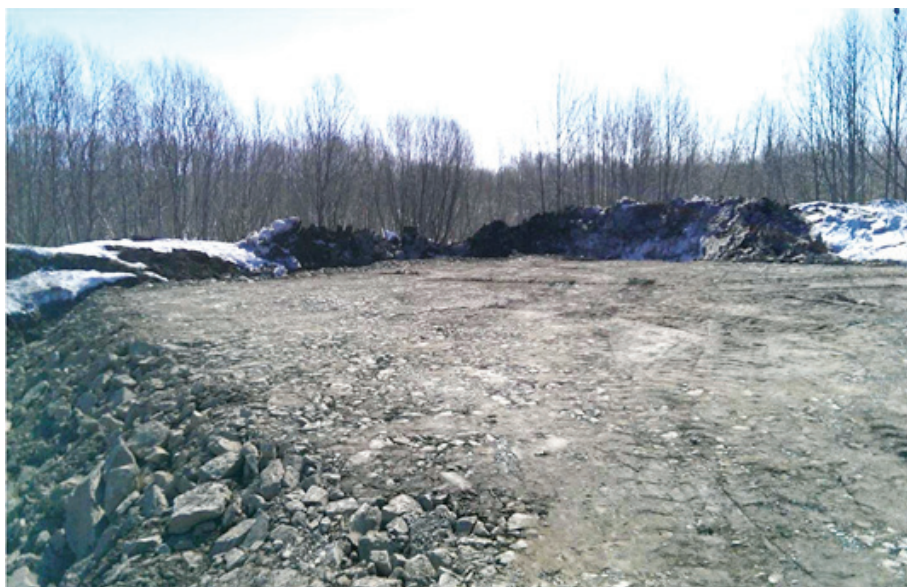
Рис. 4. Послойно уплотненный насыпной грунт
