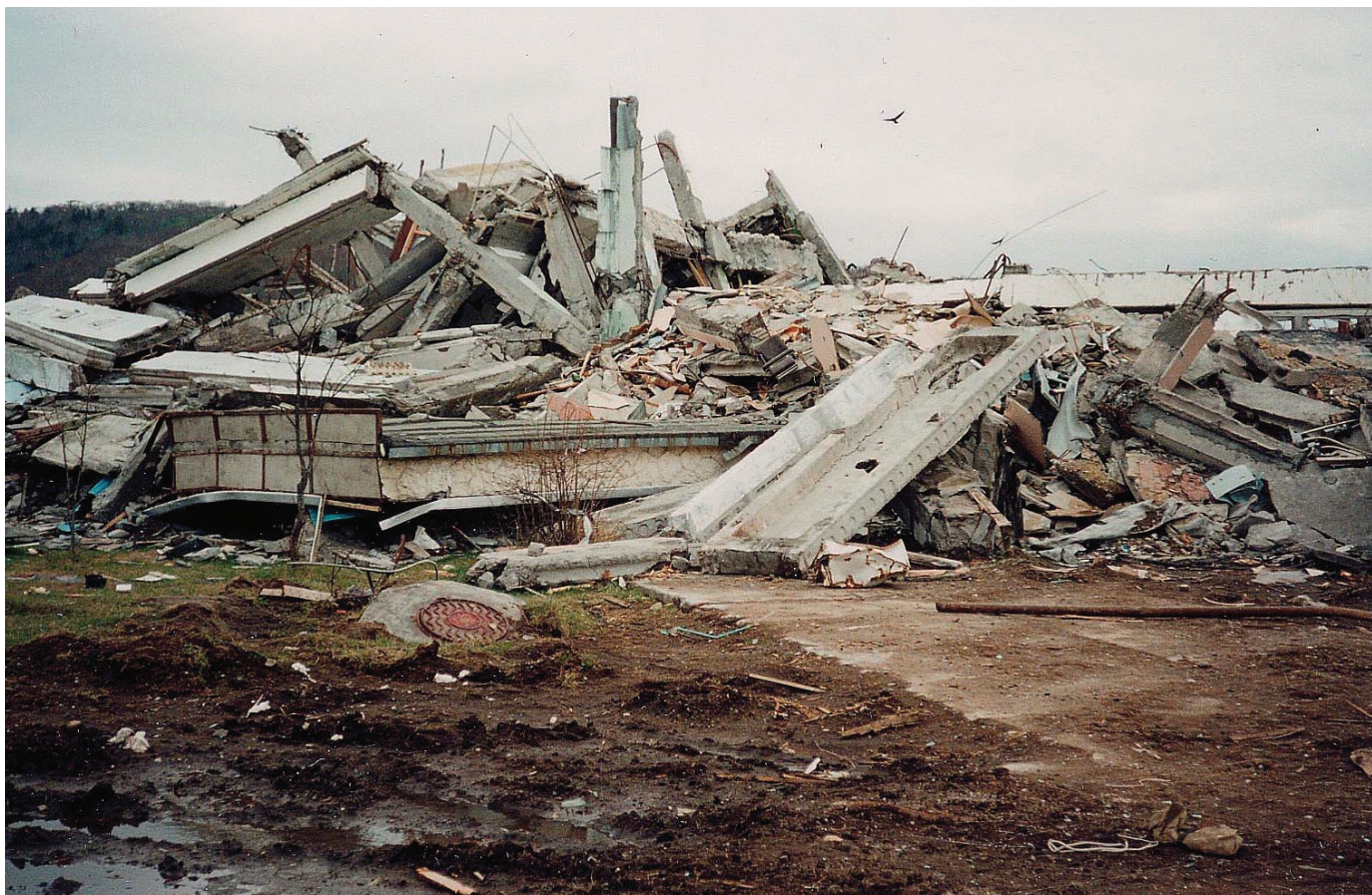
Рис. 4. Последствие Шикотанского землетрясения 04.10.1994 г. на острове Итуруп, п. Горячие Ключи. Обрушение здания госпиталя (фото Г.Л. Коффа)
