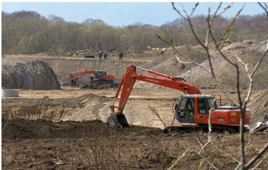
Рис. 7. Подготовка строительной площадки Камчатской краевой больницы
