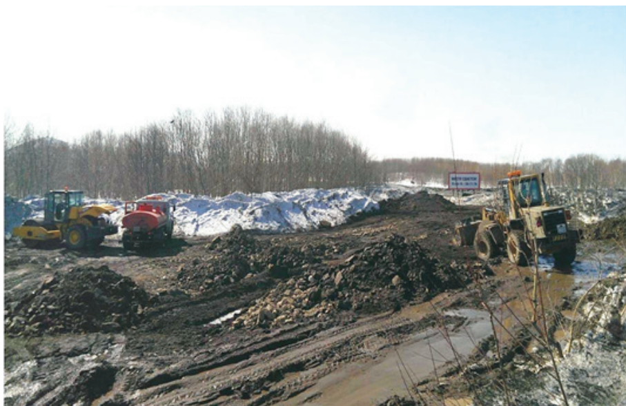
Рис. 3. Засыпка площадки щебенистым грунтом
