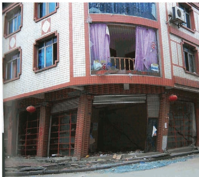
Рис. 5. Характерные для столичных городов Центрально-Азиатского региона жесткие здания с первыми гибкими этажами. Этот вид строительства не допускается нормами ряда Центрально-Азиатских стран либо допускается в ограниченном применении. Справа представлен вид повреждения зданий с гибким этажом после землетрясения в Сичуане (Китай), 12.05.2008 г., M=8,0 местечко Лонгман (автор фото слева – Ш.А. Хакимов, 2010; справа – www.zzs.iem.cn )
